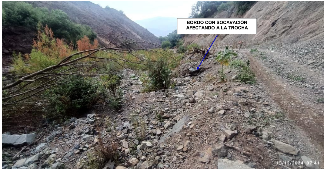
FIGURA N°03: BORDO DE LA MARGEN DERECHA AFECTADO Y LA TROCHA CARROZABLE, PRESENTA PELIGRO A SOCAVACIÓN
