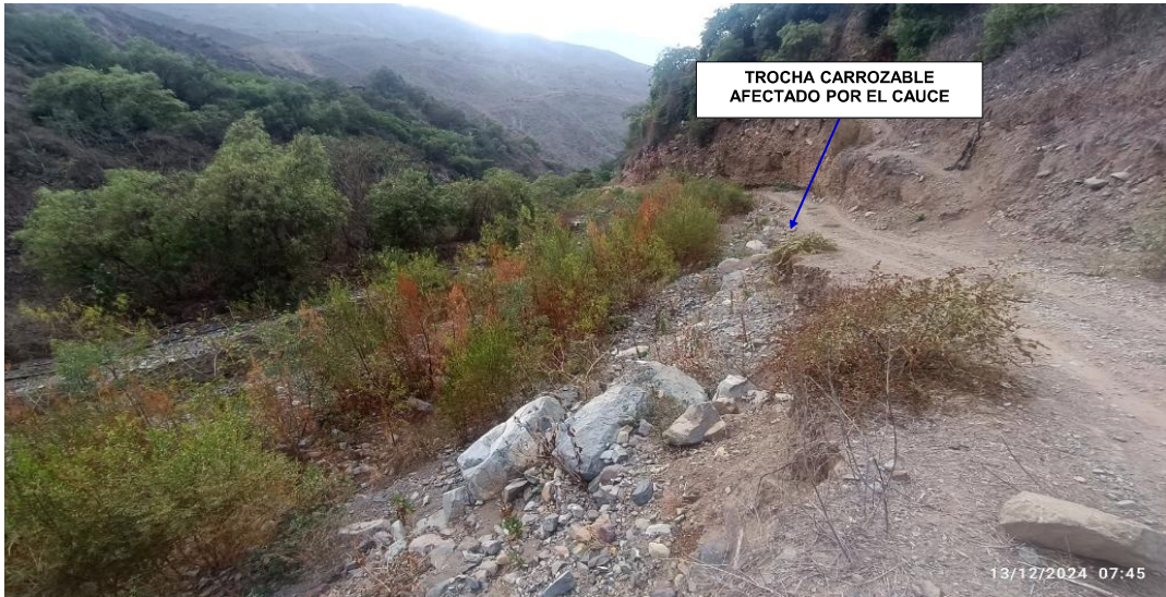
FIGURA N°04: EN LA TEMPORADA DE MAXIMAS AVENIDAS, LA TROCHA CARROZABLE ESTA EN PELIGRO A QUEDARSE EROSIONADO POR LA SOCAVACIÓN DEL CAUDAL, PONIENDO EN RIESGO A QUEDARSE SIN VIA DE ACCESO EL C.P. CALLANTAMA
