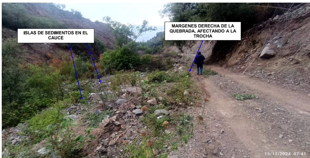
FIGURA N°02: A LA MARGEN DERECHA DE LA QUEBRADA SE ENCUENTRA LA TROCHA CARROZABLE EN DONDE EL NIVEL DE LA TROCHA ESTÁ POR DEBAJO DEL NIVEL DE LA QUEBRADA POR EXCESO DE SEDIMENTOS
